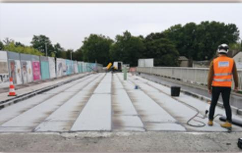
> Rincenc Investigations a réalisé des essais par thermographie infrarouge de contrôle de la pose d'étanchéité sur un Ouvrage d'Art. Les six caractéristiques principales du matériau d'étanchéité sont :
