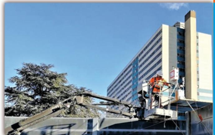
Implanté en limite de propriété du chantier un analyseur en continu des concentrations en poussières a été installé (photo jointe).
